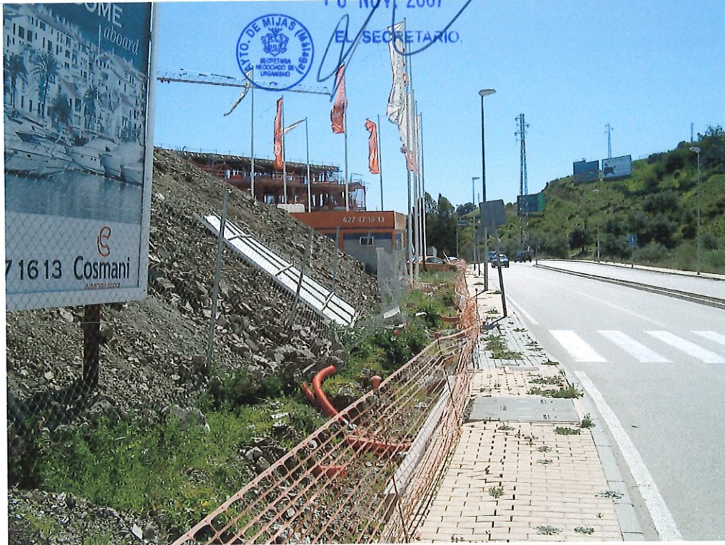
Continúa el recorrido de las tuberías de Agua Potable y Reciclada hacia La Cala, por el borde exterior de la acera, Sector SUP C-10 (aproximadamente PK 2+250).
