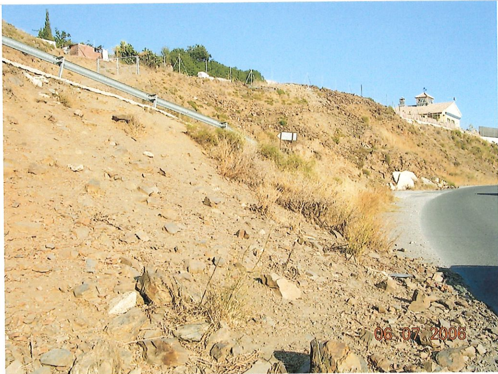
Continuación del Recorrido hacia La Cala de Mijas: Talud que necesita ser estabilizado antes de ejecutar las excavaciones para las tuberías (aproximadamente PK 2+500).
