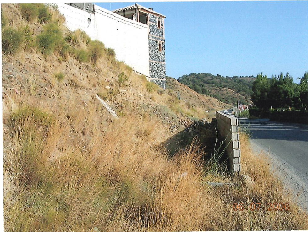
Continuación del Recorrido hacia La Cala de Mijas: Vallado alledaño al arcén, que coincide con la zona de sobre excavación que será necesario derribar y reponer (aproximadamente PK 2+580).
